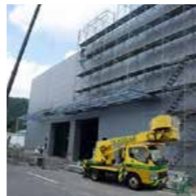
下水・水道工事
