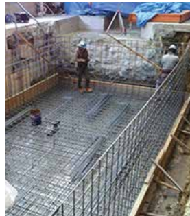
ピット設置工事
